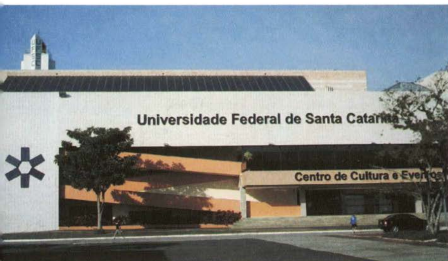
Módulos solares fotovoltaicos integrados à cobertura do prédio do Centro de Eventos da UFSC, Florianópolis.
