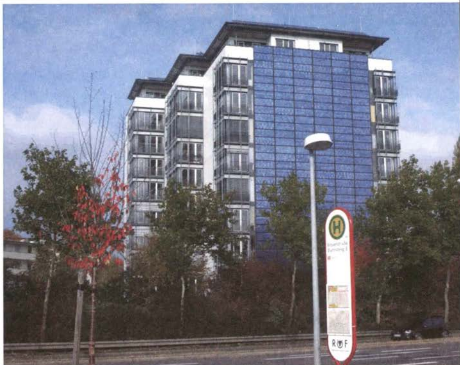
Os geradores solares podem ser configurados de forma integrada à edificação, no telhado ou fachada de um prédio, por exemplo.
