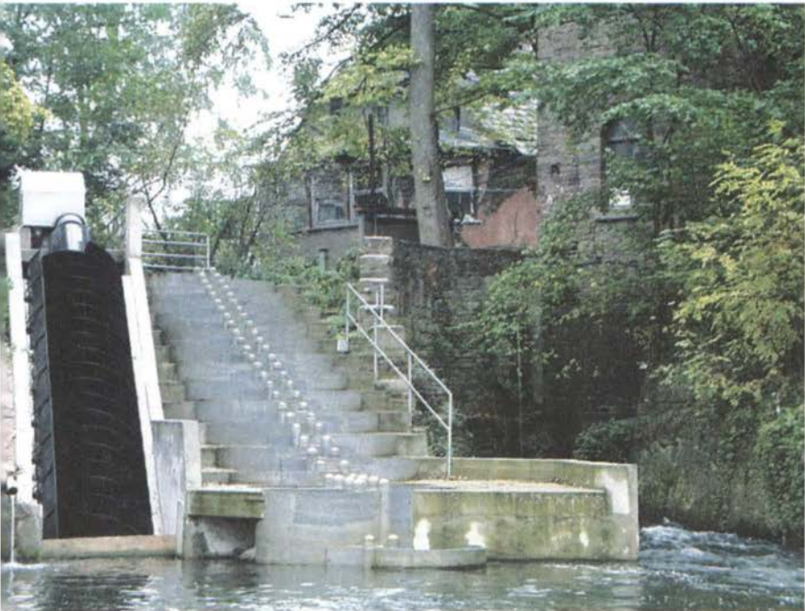
O movimento de parafuso de Arquimedes para a geração de energia elétrica também oxigena a água, garantindo a criação intensiva de peixes nas piscinas.
