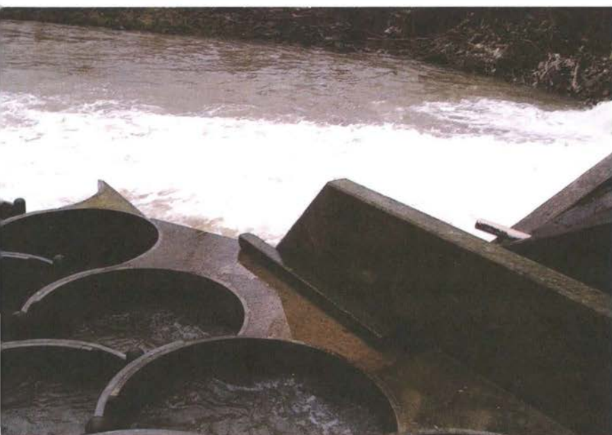
As linhas orgânicas do novo sistema favorecem os movimentos circulares característicos dos cardumes.
