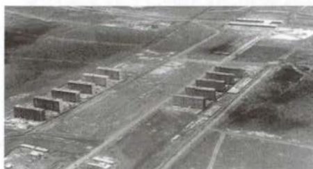
5 - Construção de Brasília –
